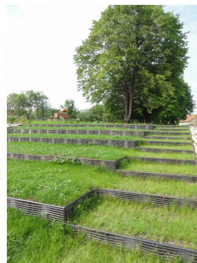
Gradins enherbés en treillis soudés
