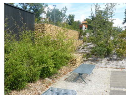
Gradins enherbés en treillis soudés
