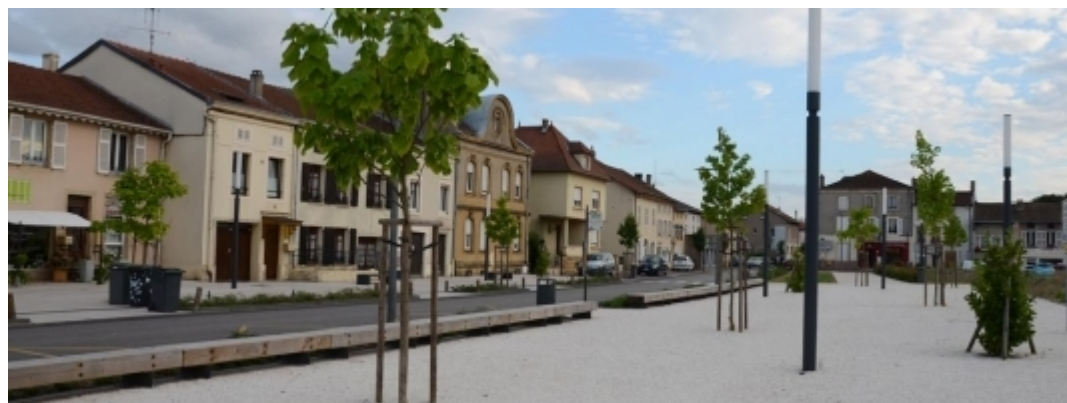
Rue Foch - Novéant-sur-Moselle (1984 habitants)
