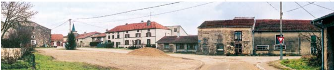
La traversée de Puzieux avant sa requalification
