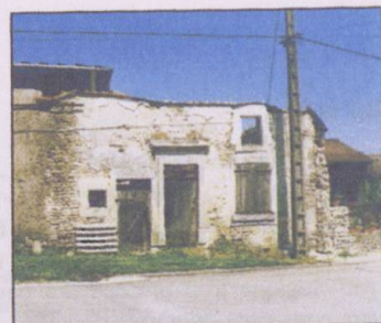
Façade en ruine sur la rue
