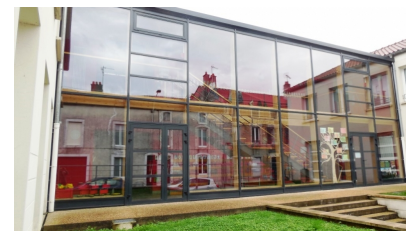
Façade en verre : en avant du bâtiment d'origine.
