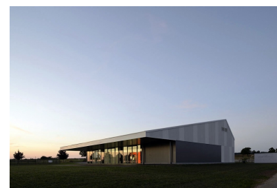
Volume du bâtiment (Crédit ph. Nicolas Waltefaugle)
