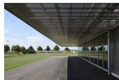
Terrasse couverte par le débord de toiture (Crédit ph. Nicolas Waltefaugle)
