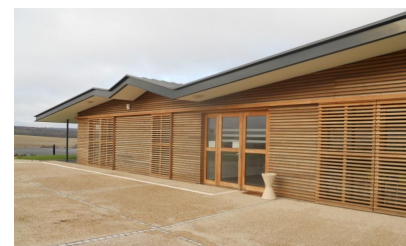
L'avancé de toiture protège le bardage bois des intempéries.
