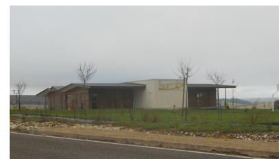
La partie monolithique centrale en béton offre une inertie thermique au bâtiment.
