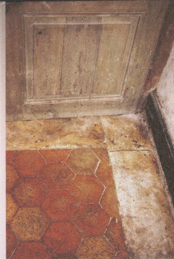
Ces tommettes de terre cuite encadrées de dalles calcaires composent un sol contrasté.
