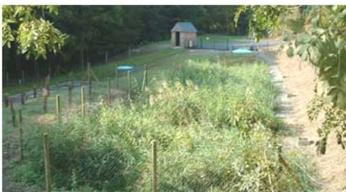
Filtre planté de roseaux ou phragmifiltre
