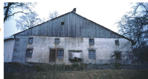
Façade-pignon pourvue d'un four à pain suspendu caractéristique de la ferme des Vosges Cristallines Montagne Sud
