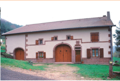
Soubassement, bandeaux, encadrements et chaînages d'angle en grès rose Pays de Remiremont
