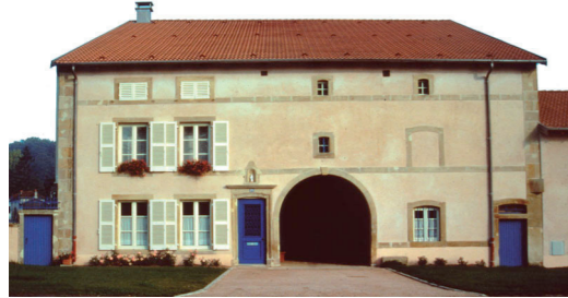
Ferme de 1840 à trois travées : composition rigoureuse avec bandeaux et chaînages d'angle en pierre de taille caractéristique du XIX ème siècle Centre-Vosges
