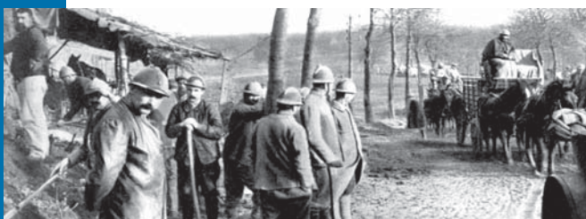
la route en travaux permanents pour rester carrossable en tout temps...
