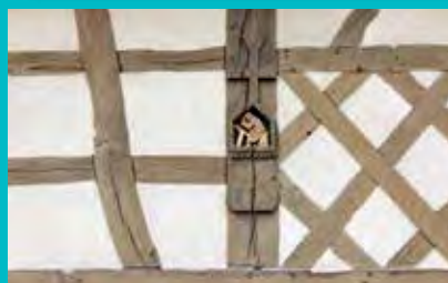
Pan de de bois : colombage avec son remplissage de torchis et l'enduit protecteur au mortier de chaux.
