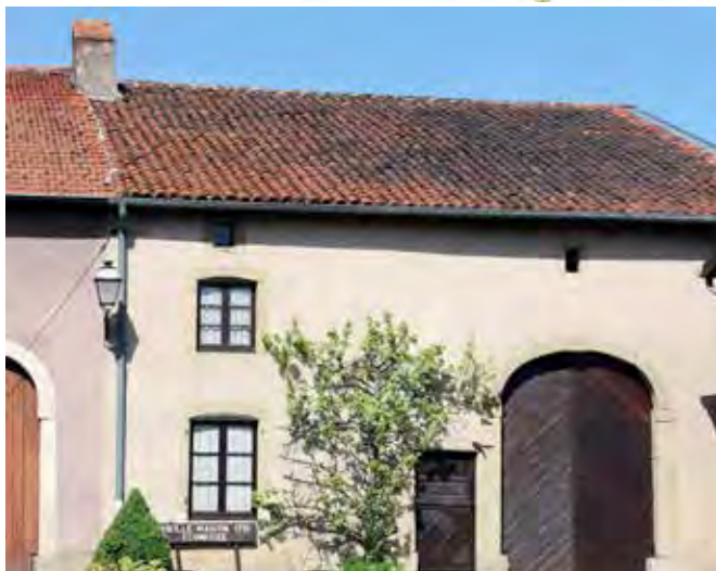
La “Vieille maison“ de Gomelange - état après restauration
