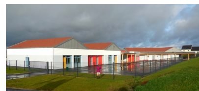
Les volumes bas assurent au bâtiment une bonne intégration paysagère.
