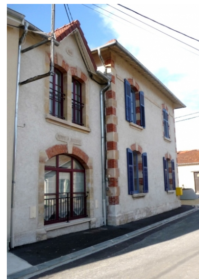
Ancien local des pompes réhabilité en logement.
