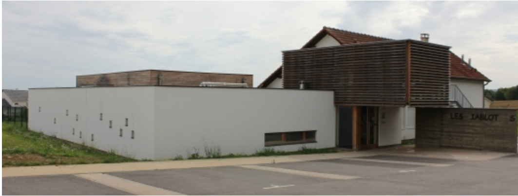
lieu-dit Ozerailles - Verny (2040 habitants)
