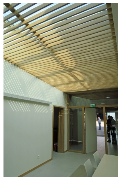
Verrière et plafond en lames de bois
