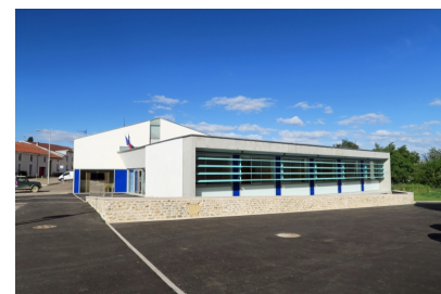
Vue générale des deux volumes
