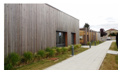
Un cheminement piéton permet un accès direct depuis le village.
